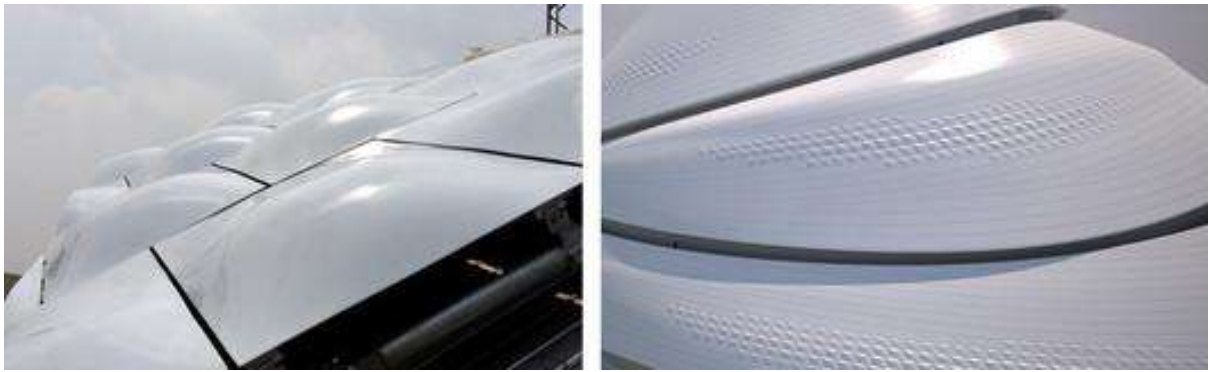
Gambar 2. 13 Pelapis Gedung Opera Harbin
