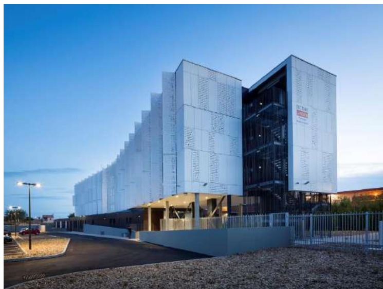
Gambar 2.16 MDR Architectes, Prancis ( Sumber : Archdaily )
