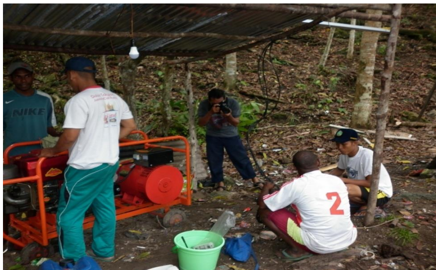
Gambar. 6 Pemasangan instalasi listrik dan genset
