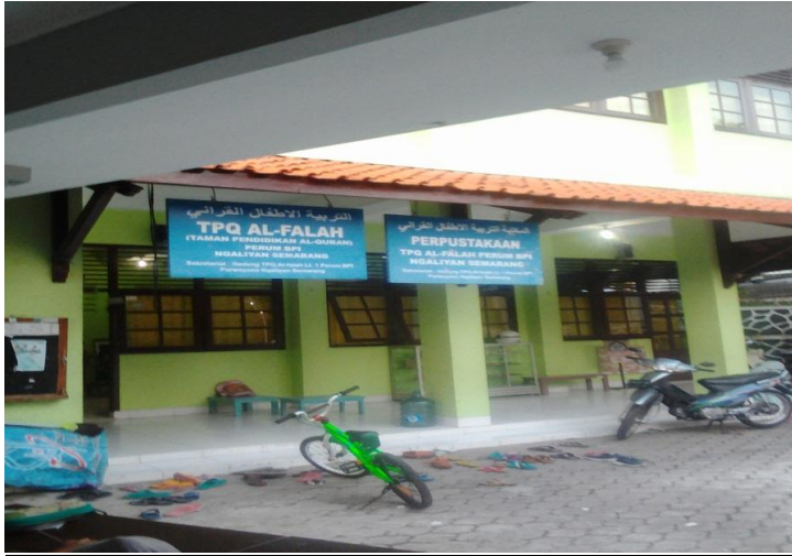
Gedung TPQ Al-Falah
