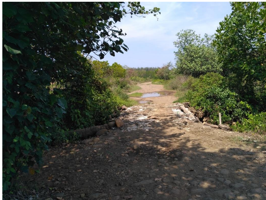
Gambar 3.5. Jembatan kedua menuju Pantai Segelok-Batang 74
